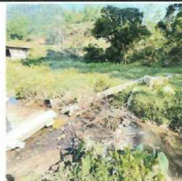
Foto 4: colapso de drenaje causado por varias razones, incluyendo lluvias intensas, acumulación de basura o materiales, o el mal estado de la infraestructura de drenaje.
