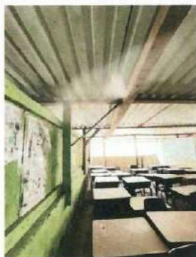
Foto 3: La deflexión puede ser un indicador de que la estructura no está diseñada adecuadamente.
