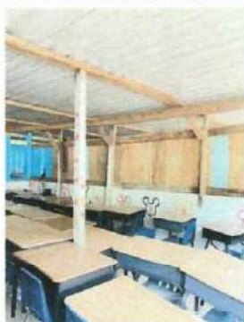
Foto 3: La deflexión puede ser un indicador de que la estructura no está diseñada adecuadamente.
