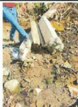
Foto 4: colapso de drenaje causado por varias razones, incluyendo lluvias intensas, acumulación de basura o materiales, o el mal estado de la infraestructura de drenaje.
